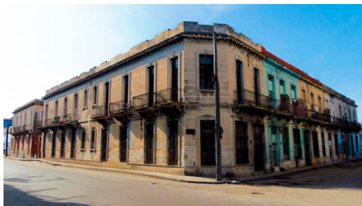
Figura 1. Casa de apartamentos en Avenida Manglar y Lindero, Centro Habana. Fuente: Foto de autoras, 2016.
