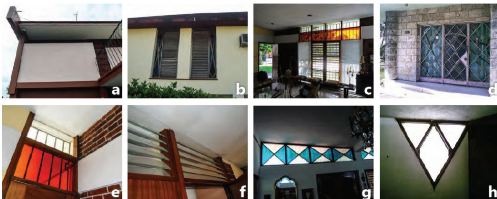
Figura 13. Carpintería: a) en paños horizontales, b) en paños verticales, c) de madera y vidrio, d) de metal y vidrio, e) y f) sin marco superior, g) con vitrales de colores, h) con geometría singular. Fuente: A.J. Rouco, 2020.
