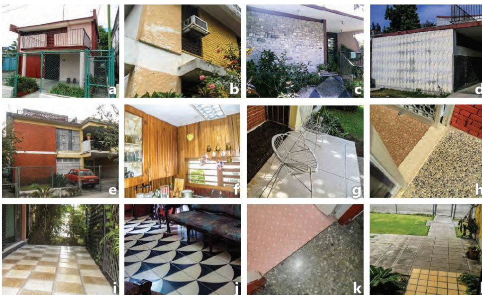
Figura 12. Revestimientos en muros: a) repello liso, b) repello rústico, c) enchape con piedras naturales, d) enchape con piezas artificiales, e) mixto, f) enchapes de madera en interiores. Pisos: g) de terrazo integral pulido, h) de terrazo integral lavado y en baldosas, i) de terrazo en baldosas y a relieve, j) de losas hidráulicas, k) de gres cerámico, l) de hormigón lavado y piezas antirresbalables. Fuente: A.J. Rouco, 2020.
