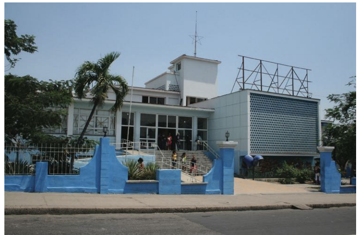
Figura 10. Distrito Oeste de Obras Públicas, Cienfuegos. Fuente: Autor, 2008.
