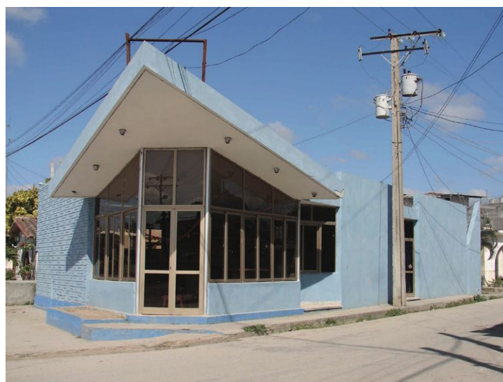
Figura 6. Oficinas Comerciales para Créditos Latorre S.A. Arq. Félix Pina. Fuente: Autor, 2011.
