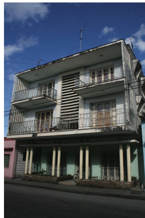
Figura 4. Edificio de apartamentos para Francisco G. Linares, Sagua la Grande, 1958. Arq. Eduardo Martínez. Fuente: Autor, 2009.
