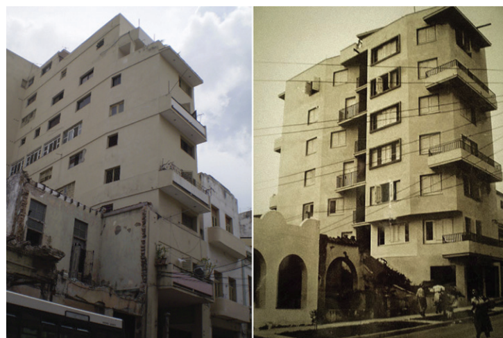
Figura 8. No se trata del mismo edificio, aunque el ritmo de los balcones en voladizo los hace muy similares. Izquierda: Edificio TRANSACO, Galiano No.115, Centro Habana, 1954 (Tabla 1, No. 18). Derecha: Edificio Dúplex, Ave. 63, Marianao, 1953- 1956 (Tabla 1, No.15). Fuentes: Autor (izquierda) y fondos fotográficos del Archivo Nacional de Cuba (derecha).
