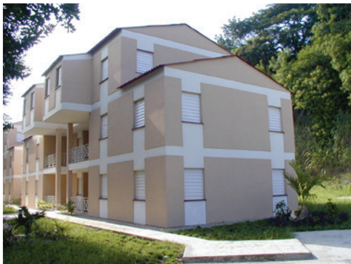
Figura 9. Viviendas construidas en la Calzada de Puentes Grandes, municipio Plaza de la Revolución con el sistema constructivo MET EPS. Proyecto: Mario Girona y Dolly Gómez (TICSA). Fuente: Foto de la autora
