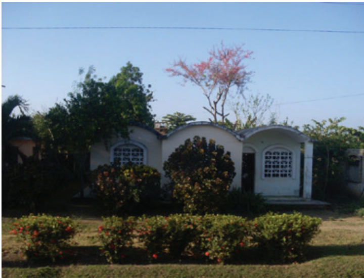
Figura 8 Vivienda de bajo consumo construida en la provincia Granma con celosías de mortero en sustitución de las ventanas. Fuente: Foto de la autora.
