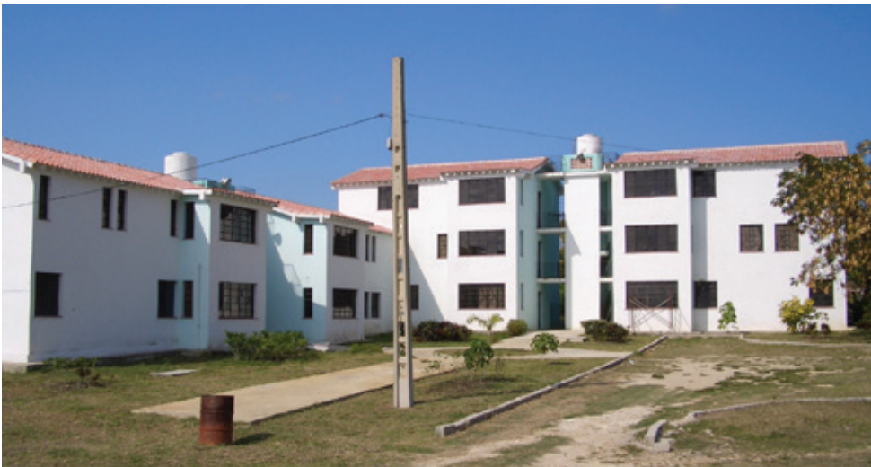
Figura 3. Conjunto de viviendas para trabajadores de la CUJAE construido con entresijos y cubiertas de losa canal de ferrocemento y terminación con tejas de micro-hormigón (TEVI), 1996. Proyecto: Emilio Escobar y Hugo Wainstock. Fuente: Foto de la autora.
