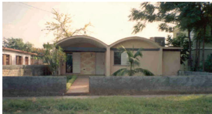
Figura 1. Primera vivienda construida con bloques machihembrados de suelo-cemento. Matanzas, 1992. Proyecto: Dania González Couret y Nelson Navarro Campos. Fuente: Foto de la autora.
