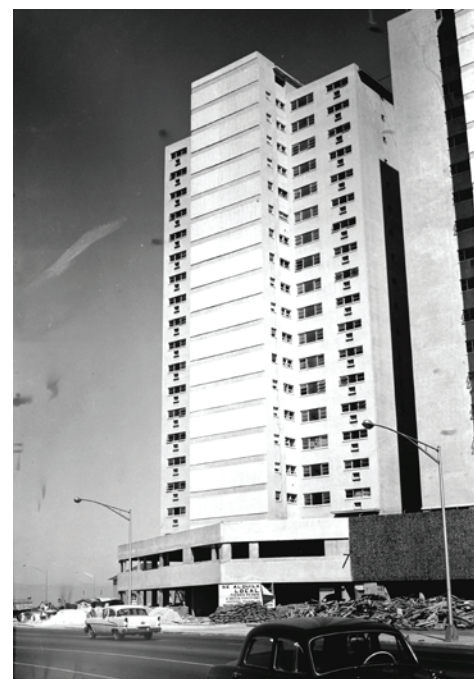
Figura 3. Torres convertidas en residencias estudiantiles. Dirección: 12 #16 (Tabla 1-No 49). Fuente: Archivo fotográfico del MOP.
