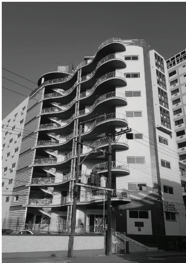
Figura 18. Edificio de O #216-218 (Tabla 1-No 3). Fuente: A.J. Rouco.
