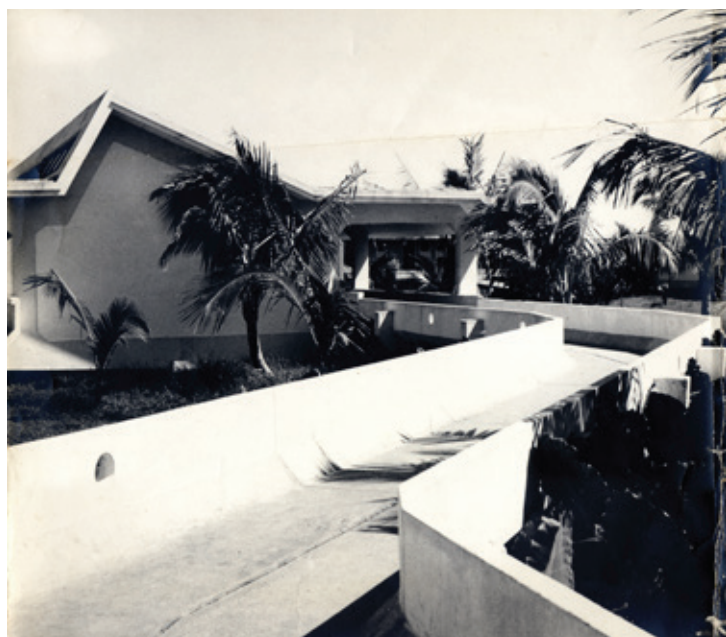
Figura 18. Pasarela aérea de hormigón. Fuente: Archivos del antiguo Ministerio de Obras Públicas. Cortesía de Khristian Zecchin.
