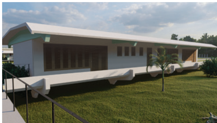
Figura 13: Vista general del dormitorio de profesores. Fuente: Autores. Modelación digital de Andy Díaz Cabrera.
