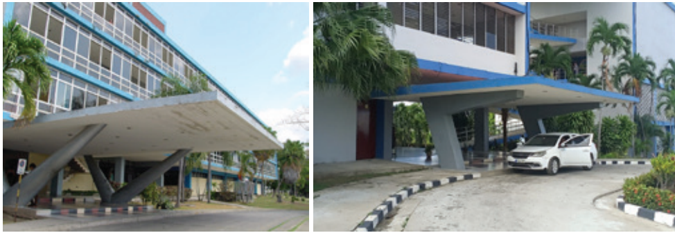
Figura 8. Accesos principales del edificio del Rectorado. Fuentes: René Silveira, 2017, J. Drago, 2024
