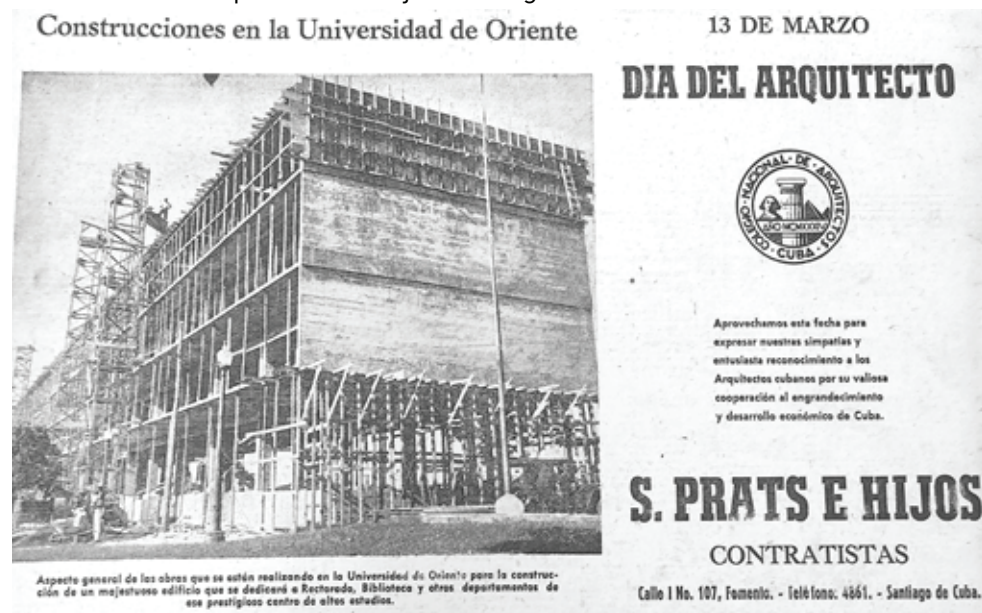
Figura 6. En pleno proceso de construcción el edificio del Rectorado, donde se visualiza la experticia de los contratistas. Fuente: Diario de Cuba, jueves 13 de marzo de 1958, p.3.
