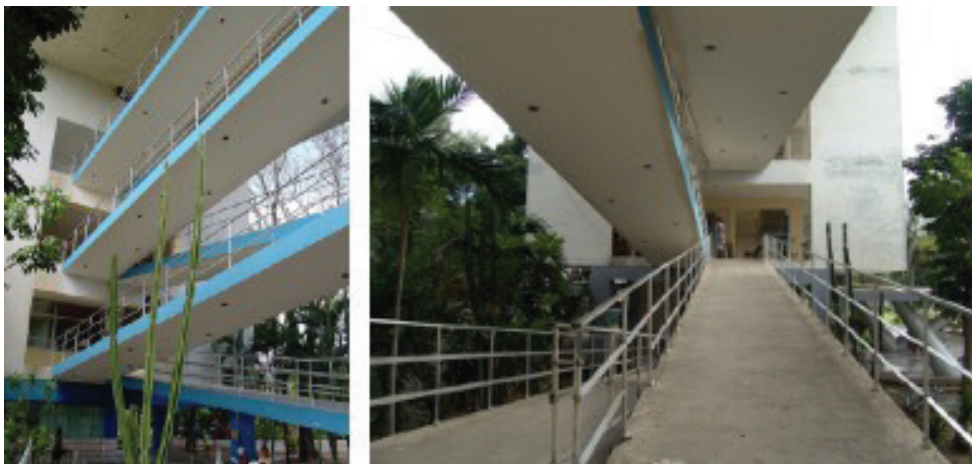
Figura 9. Rampas que interconectan los diferentes niveles del edificio y lo dotan de una singular expresión. Fuente: René Silveira, 2017.
