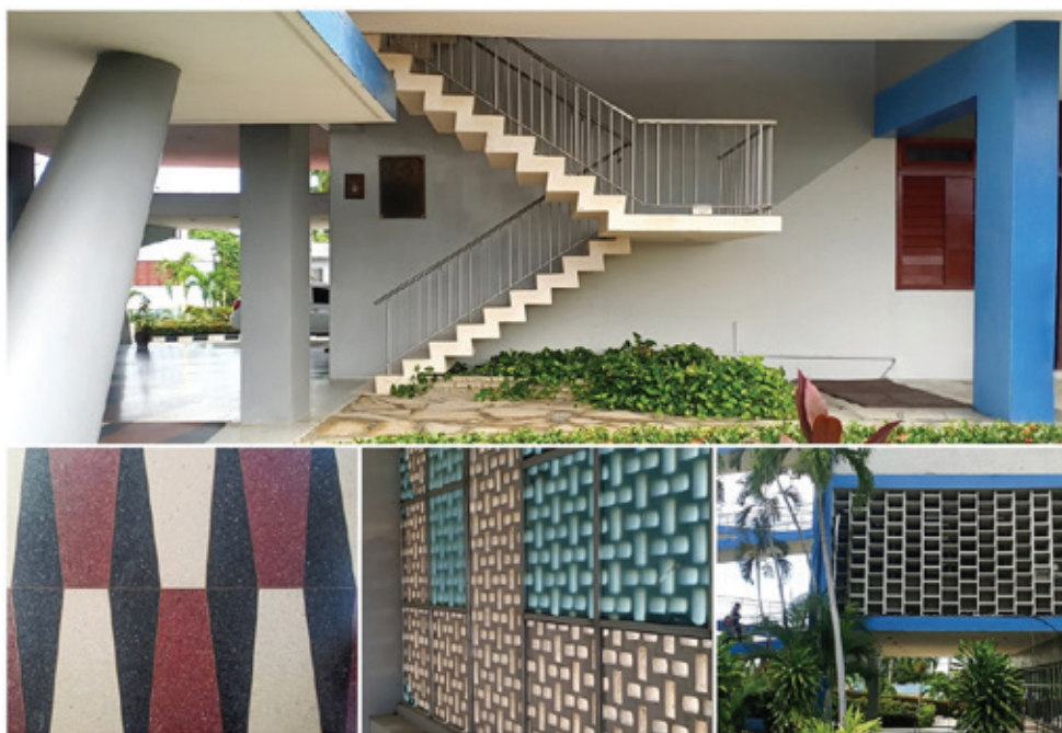
Figura 12. Imágenes que expresan audacias estructurales y diversidad de terminaciones. Fuente: J. Drago, 2024.
