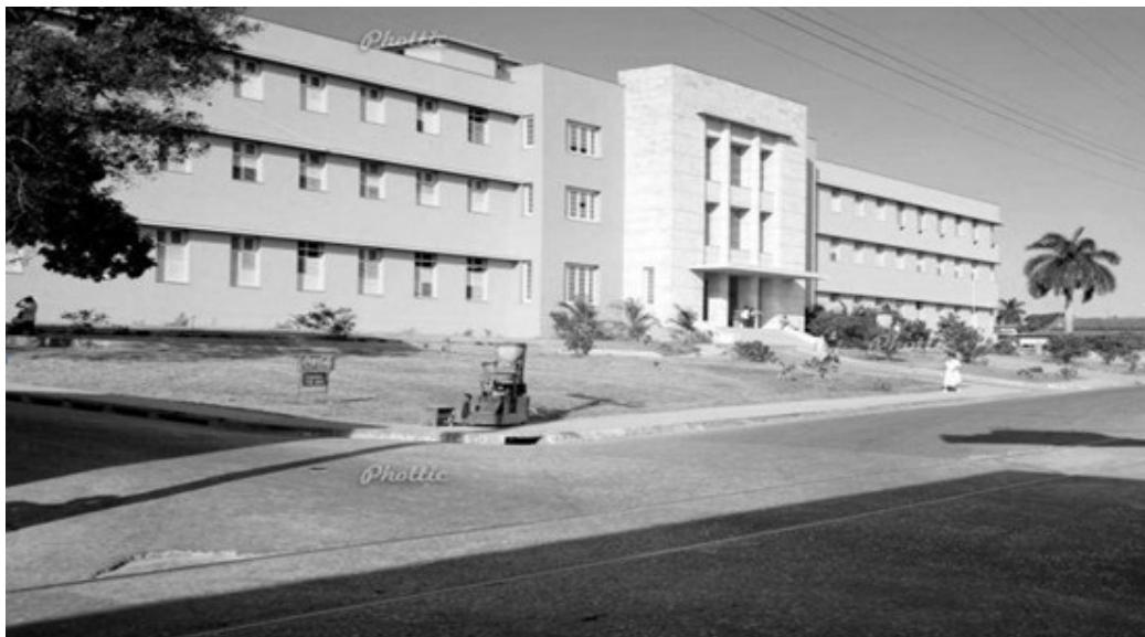
Fig. 2. Remodelación del hospital civil de Matanzas.
