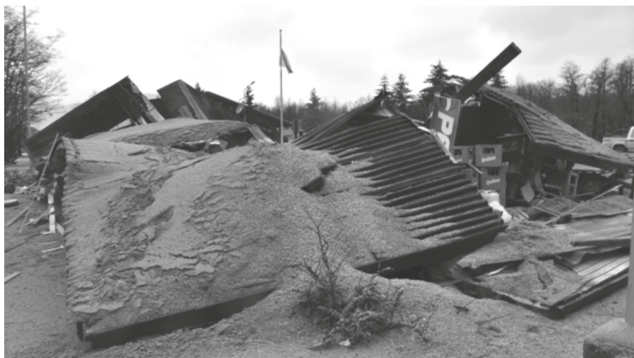
FIGURA 8. Los efectos de la ceniza volcánica en los techos. Paso Internacional Cardenal Samoré, Neuquén. 2011. Imagen captada el 8 de Junio de 2011, 4 días después de iniciada la erupción Fuente: Gustavo Villarosa y Valeria Outes.
