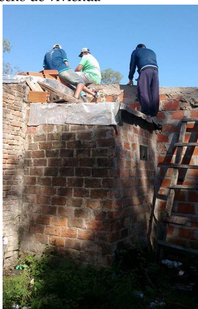
Figura 8. Reparando techo de vivienda
