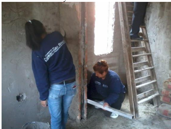
Figura 10. Paredes levantadas y revocadas
