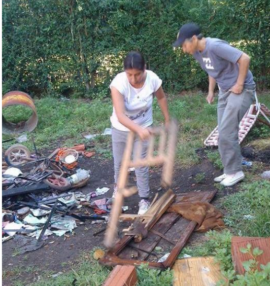
Figura 4. Refacciones en una vivienda
