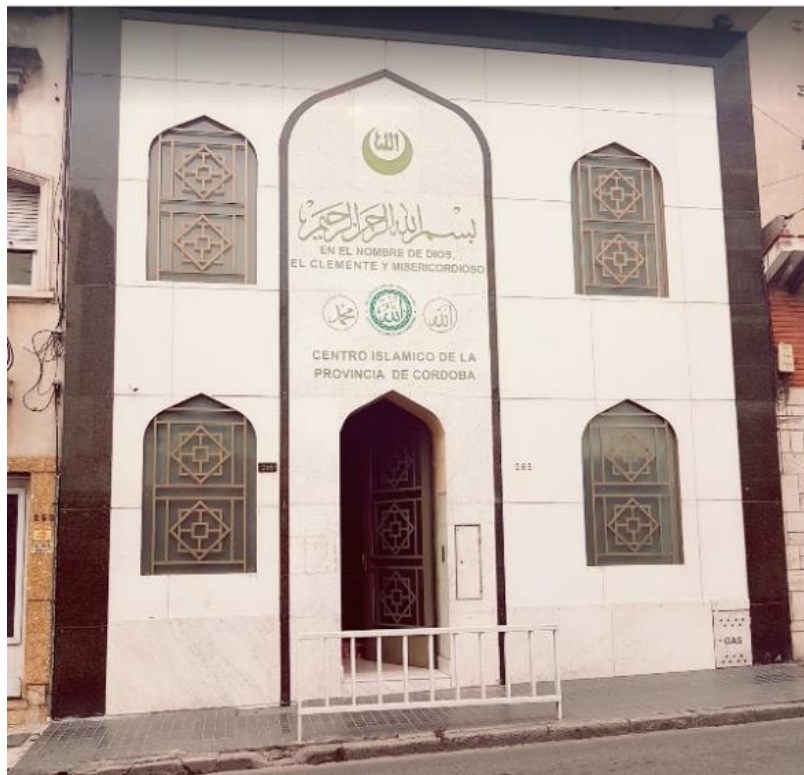
Figura 1. Foto de la fachada de la institución Sociedad Árabe Musulmana-Centro Islámico de Córdoba. Imagen extraída de internet.
