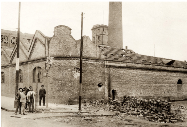
Fig. 1. A. de Barros Lobo, Fábrica Crespi após bombardeios , Mooca, São Paulo, 1924. Fonte: Acervo Instituto Moreira Salles, São Paulo, 2015.
