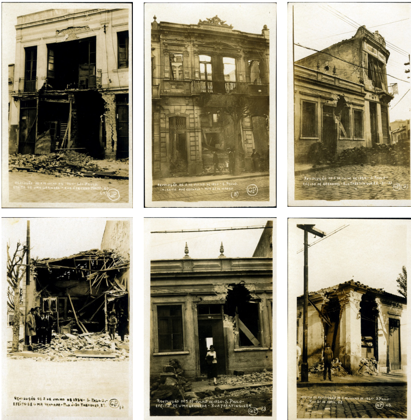
Fig. 4. Registros fotográficos de Gustavo Prugner, da esquerda para a direita: 1) Efeito de uma granada, rua Caetano Pinto, 80, São Paulo, 1924; 2) Incêndios por granada à rua 25 de março, São Paulo, 1924; 3) Efeitos de granadas na rua Tabatinguera, n.121-123, São Paulo, 1924; 4) Efeitos de uma granada na rua João Theodoro, n.22, São Paulo, 1924; 5) Efeitos de granadas na rua Tabatinguera, São Paulo, 1924; 6) Efeitos da Revolução de 1924 – Rua 21 de abril, São Paulo, 1924. Fonte: Acervo Instituto Moreira Sales, São Paulo, 2015
