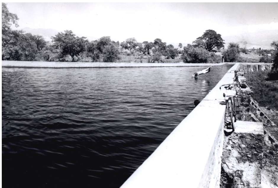
Figure 4. Photo du réservoir de la source Las Tazas, en février 1963.
