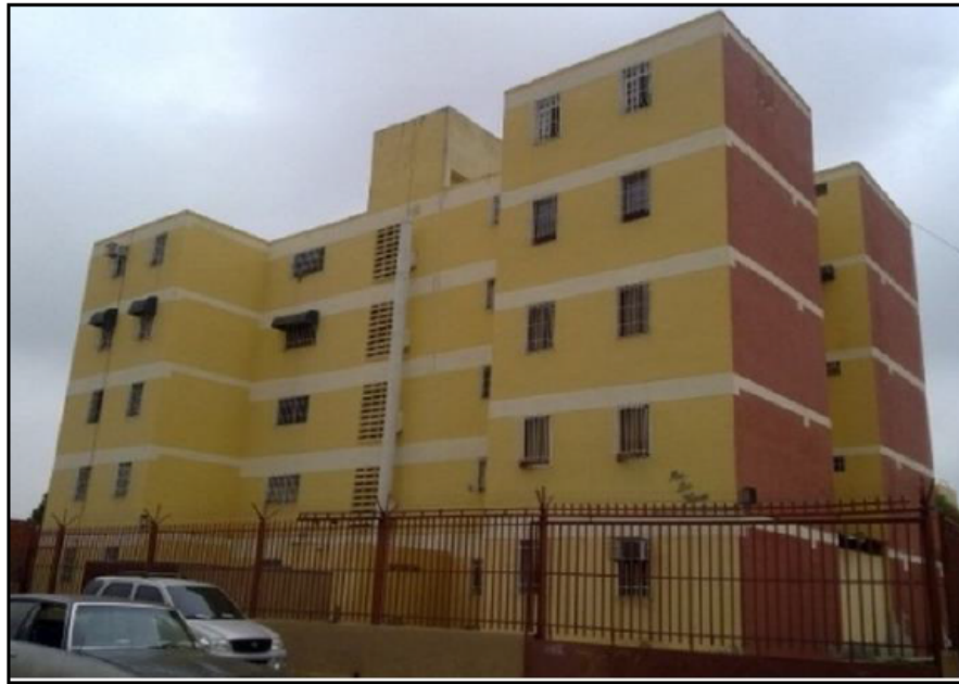
Figura 2. Edificación original (fuente Herrera et al. 2013).
