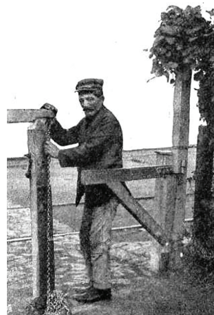
Figura 7. Guardavía cerrando las barreras
