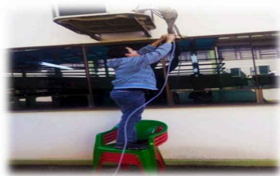
Figura 1 – Instalação da mangueira de nível
