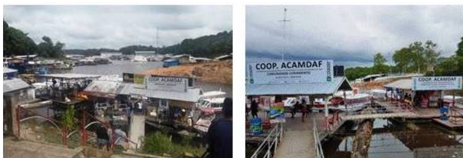
FIGURA 3 Marina do Davi - Vista da escadaria (A) / Entrada da Cooperativa (B) Gaspar (2018).
