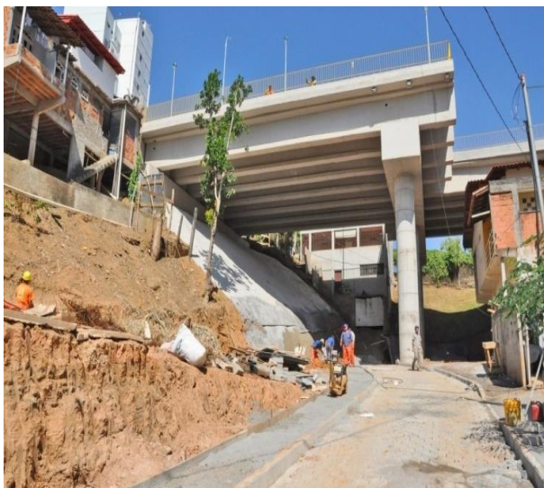
Figura 1. Obras do Viaduto José Passos
