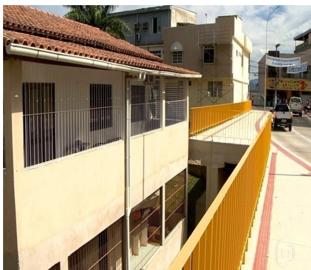
Figura 3. Distância das moradias ao viaduto José Passos
