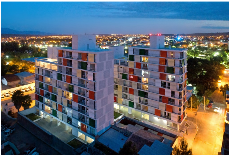
Figura 4. ProCreAr Paraná. Bloques generando espacios públicos con equipamientos comerciales en plantas bajas. Emplazamiento periférico en área de expansión, con continuidad de trazas viales con barrios adyacentes. Población de ingresos medios y bajos. La arquitectura ofrece oportunidad de integración con el barrio existente a través de los espacios públicos. Fuente: Google Maps.
