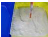
Figura 1. Mezcla de la pintura con ayuda de un revolvedor para taladro. Fuente: Fotografía de Natalia Franco Ruiz Ciudad Madero (2020).
