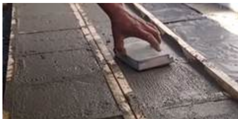
Figura 1. Aplicación del acabado fino en los sustratos. Fuente: Fotografía de Natalia Franco Ruiz Ciudad Madero (2020)
