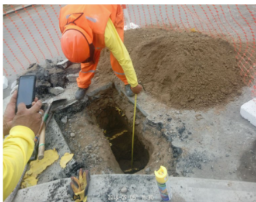
FIGURA 1. Construcción, demolición y excavación de zanjas [8]
