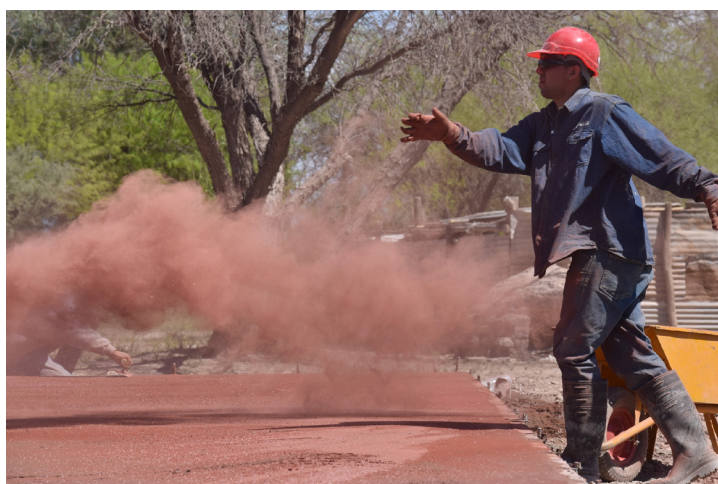
Figura N° 4: Construcción del playón.
