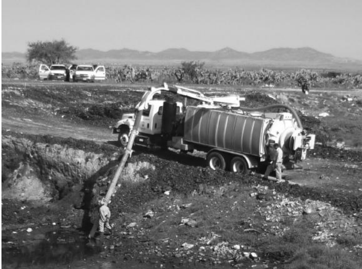
Foto 3. Uso del camión Hidroneumático Acuatech para desazolve
