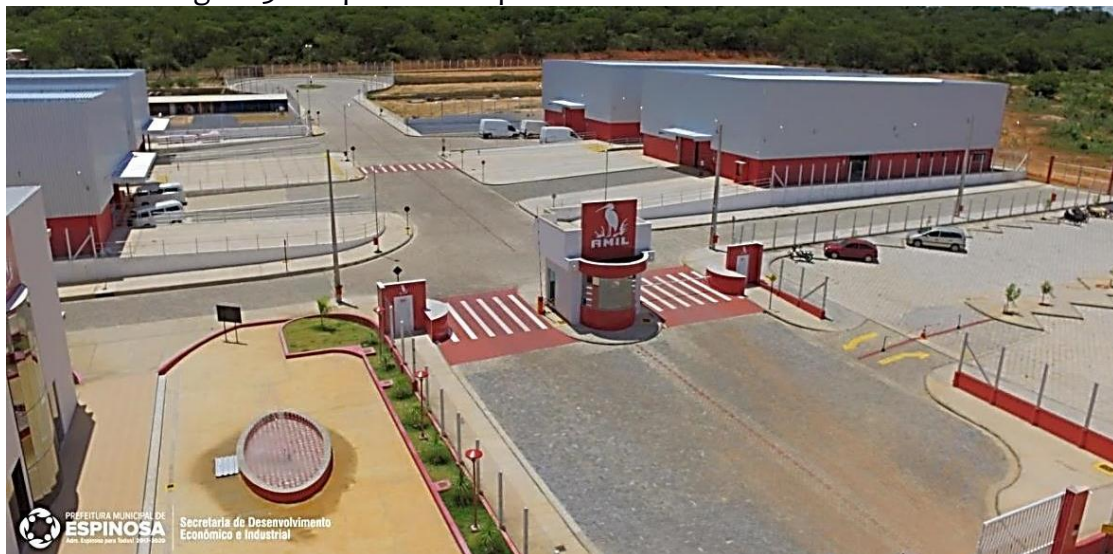
Figura 3 - Galpões da empresa âncora no Distrito Industrial
