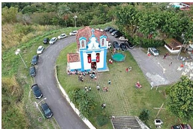
Figura 1- Capela Mont Serrat, a construção mais alta da região
