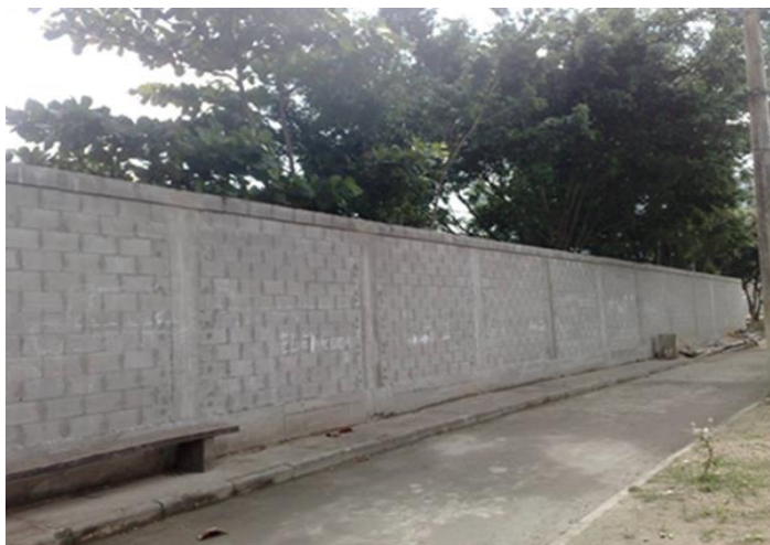
Figura 4 - Construção de muro com cerca de 400 m de extensão junto à Comunidade Novo Palmares
