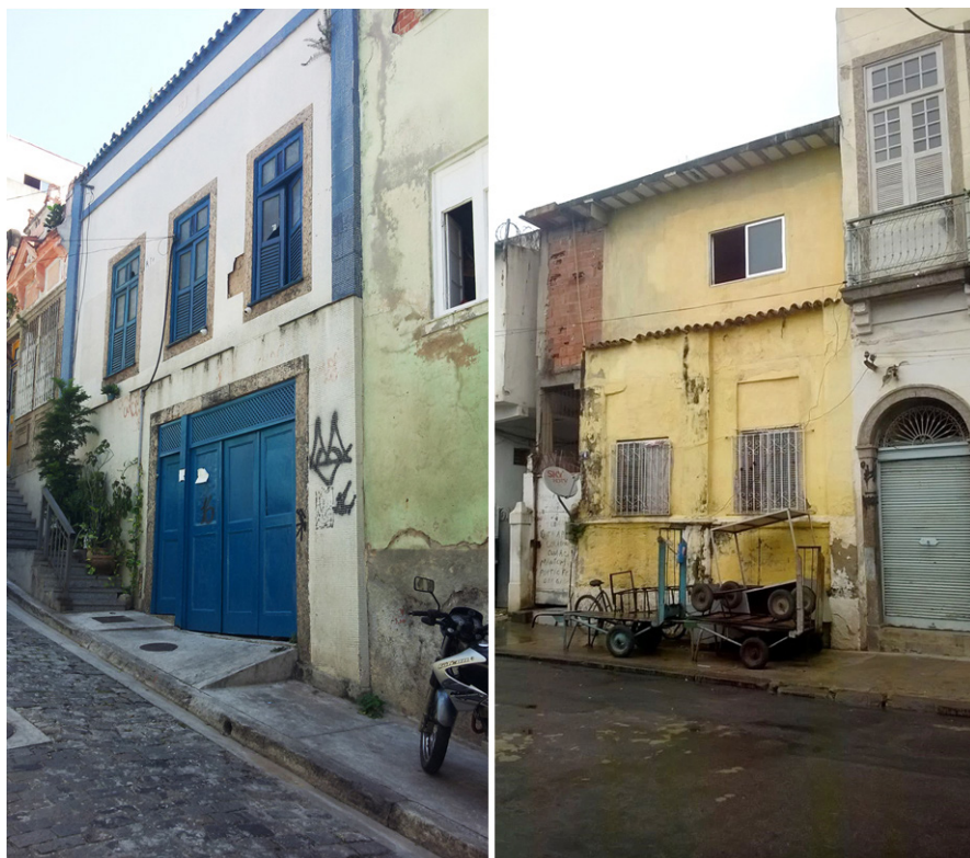
Figura II - Fachadas de cortiços identificados na Área Portuária, 2016.
