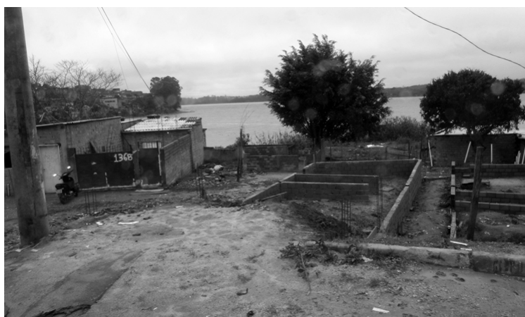
Foto 8: Em Cantinho do Céu/SP, com a paralisação das obras, um trecho onde haviam sido removidas casas para a implantação do parque voltou a ser ocupado com novas construções.
