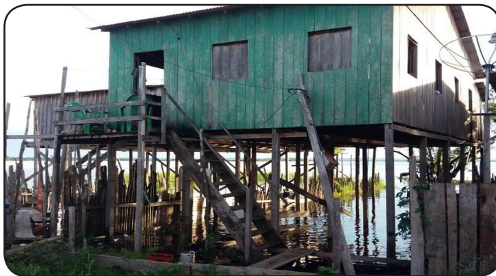
Figura 03 – Casa em palafita bairro Santo Antonio.
