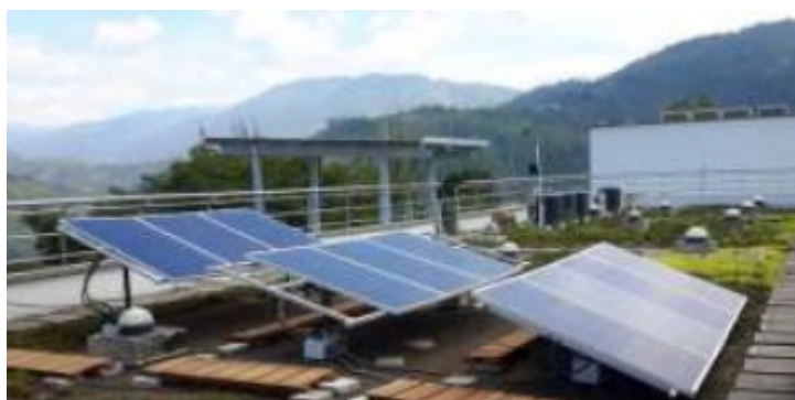
Figura 1. Sistema FV2 de inyección a la red.
