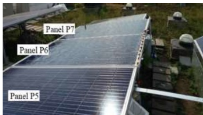
Figura 5. Paneles FV en estado de irrigación. Fuente. Elaboración propia.
