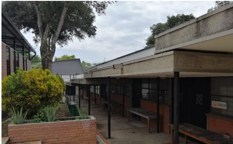
Figura 1. Estructura de acceso. Fuente: elaboración propia.
