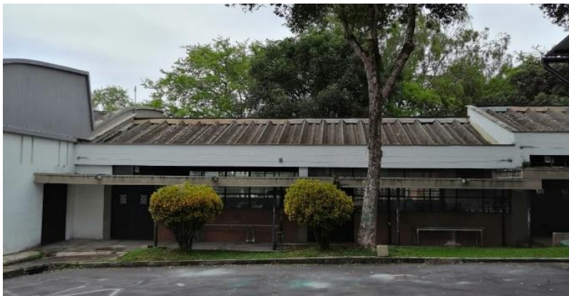
Figura 2. Vista lateral de la estructura de acceso. Fuente: elaboración propia.
