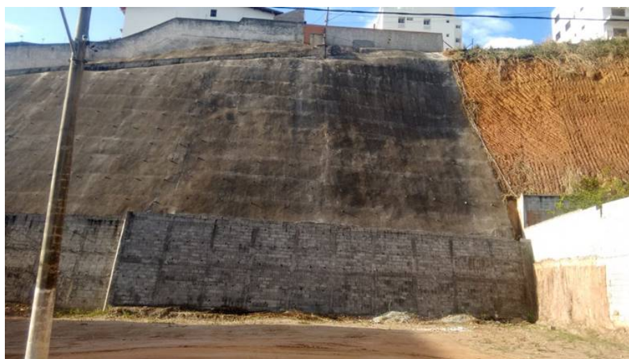
Figura 5 – Contenção I Fonte: Autoria própria.
