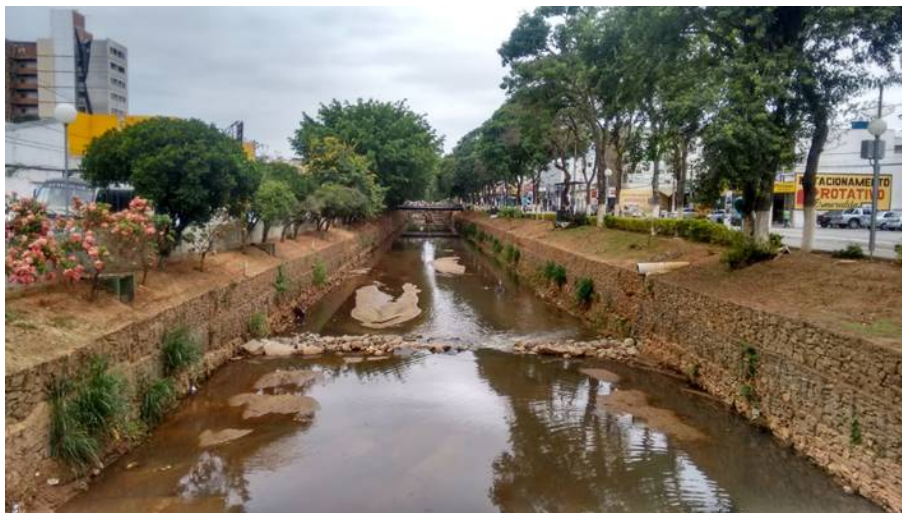
Figura 8 – Contenção III Fonte: Autoria própria.
