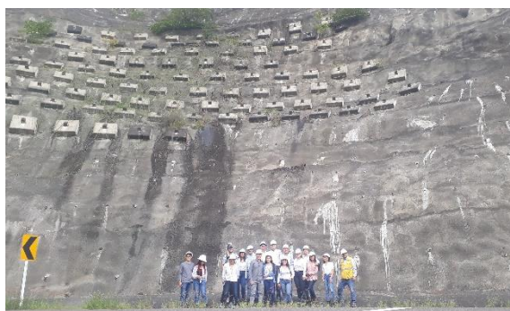
b) Reconocimiento de estructuras de contención
