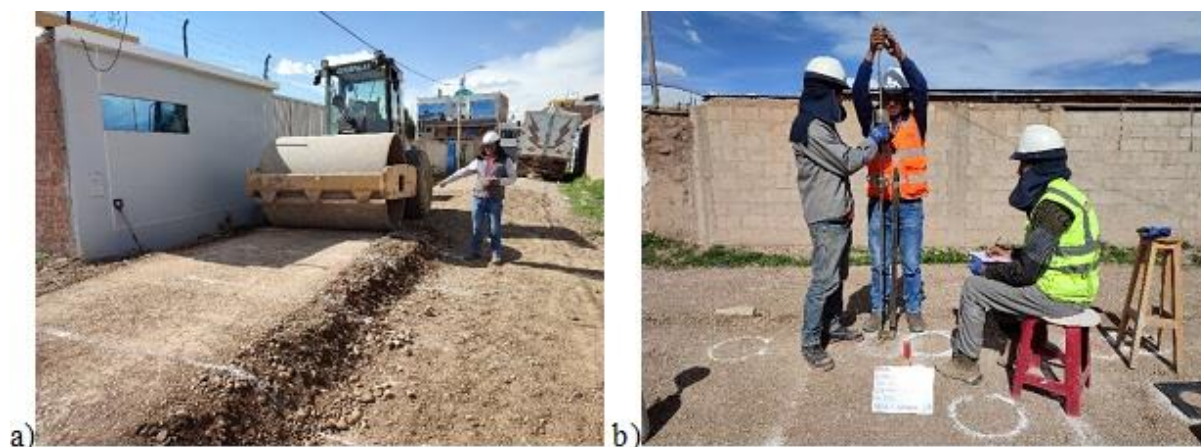
Figura 6. a) Compactación del relleno de pruebas con rodillo, b) prueba de DCP. Fuente: los autores
