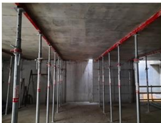
Figura 1. Proceso de cimbrado, clareado y descimbrado. Fuente: [2]
