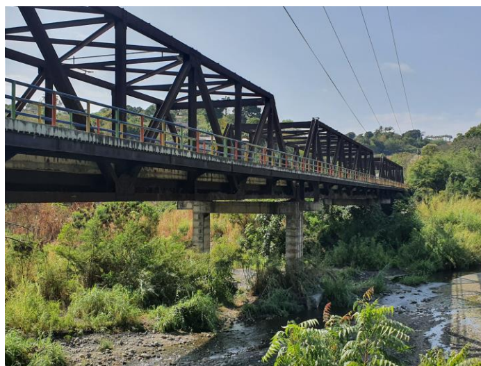
Figura 1. Superestructura de un puente de armadura. Fuente: [11]
