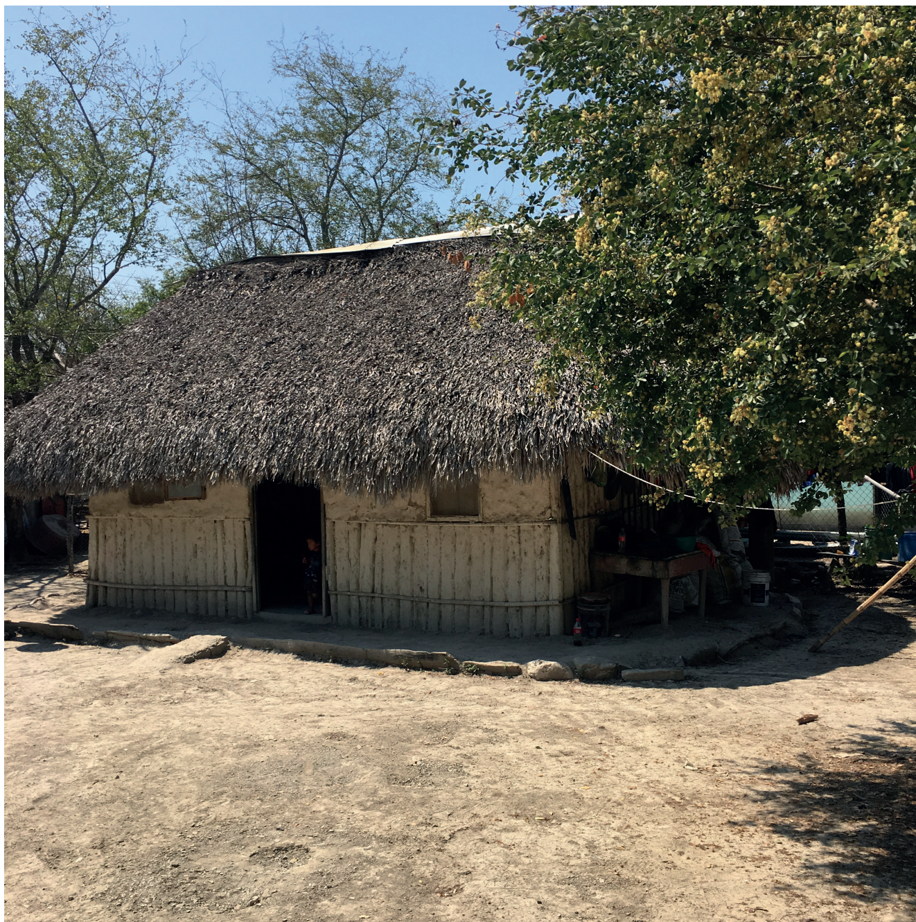
Figura 2: Casa tének de la Huasteca Potosina, México, hecha con culmos de otate ( Guadua velutina Londoño & L.G. Clark) con la técnica bahareque o enjarre (recubiertos con barro).
