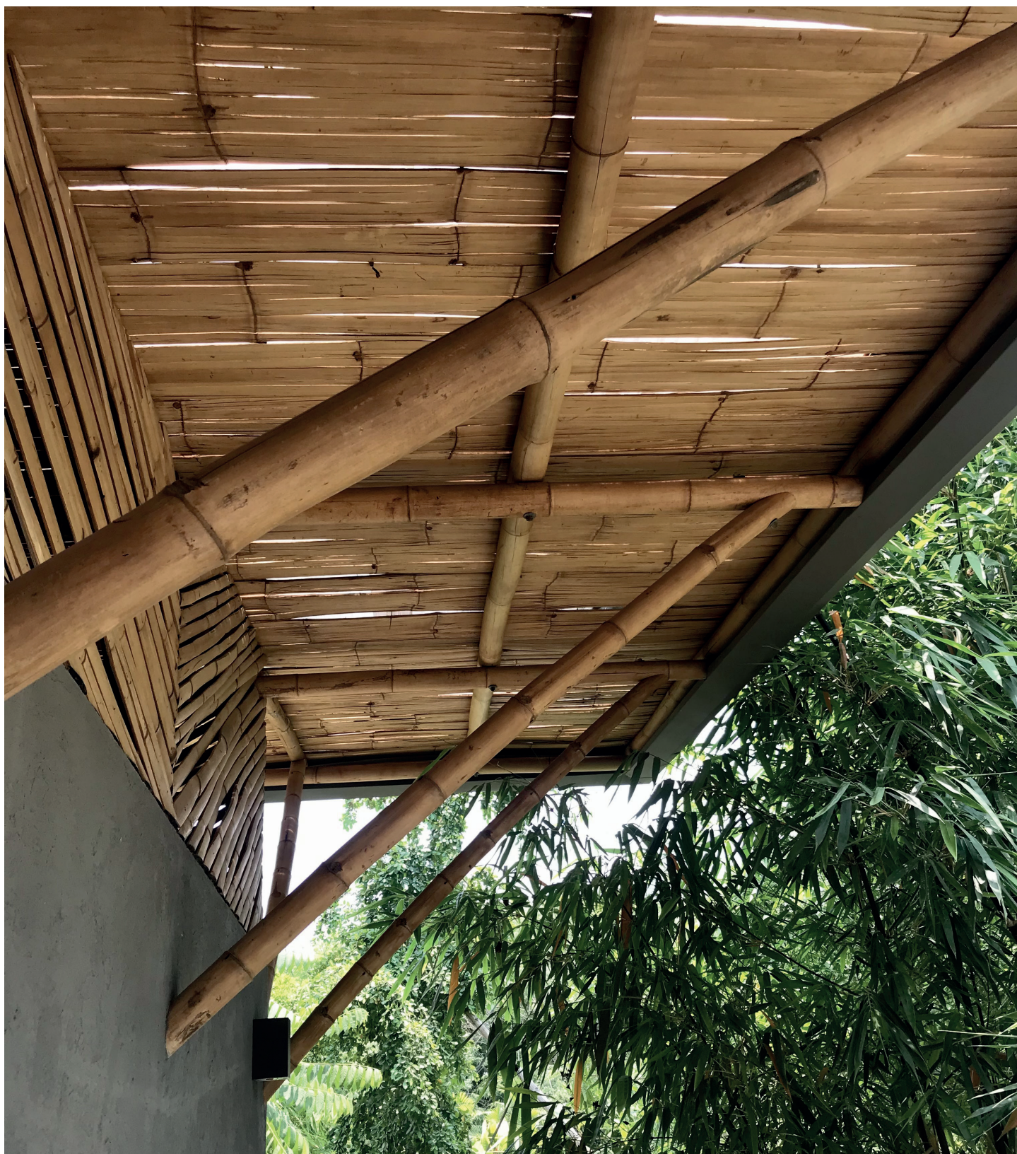
Figura 6: Plafón de esterilla y soportes hechos con Bambusa oldhamii Munro en estructura de carga. Hotel Gran Tamoanchan, Xolol, San Luis Potosí, México.
