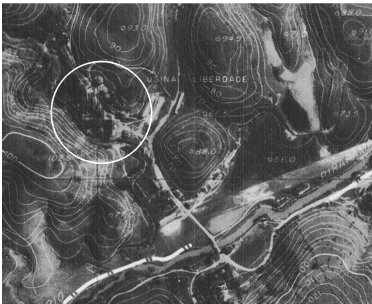
Figura 11 – Detalhe aéreo do parque industrial da Usina Liberdade
