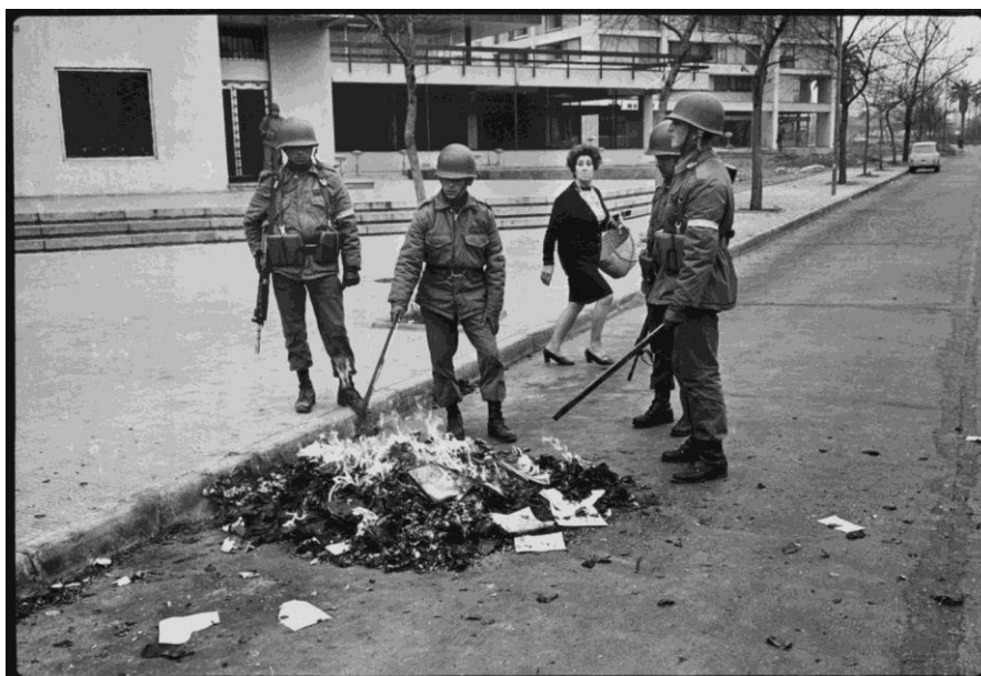
Figura 2 - David Burnett. ‘Queima de livros na Avenida Paraguai, Santiago’. Fonte: Burnett (1973).
