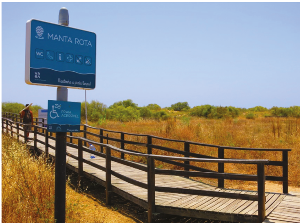
Figura 6. Pasarela en playa Manta Rota, Algarve, Portugal (2017)
