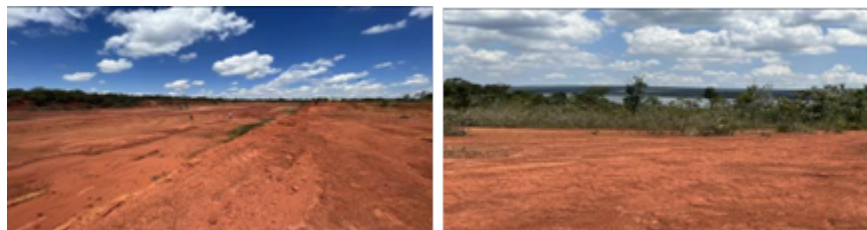
Figura 3– Processos erosivos nas proximidades da Represa Santa Maria no PNB – área utilizada como “caixa de empréstimo” para a construção da represa
