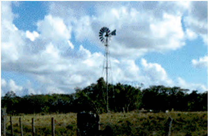
FIGURA 4. Molino instalado en finca ganadera.
