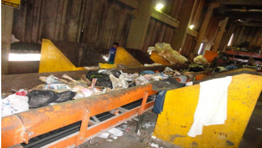
FIGURA 1. Área interna de esteiras da Usina.
