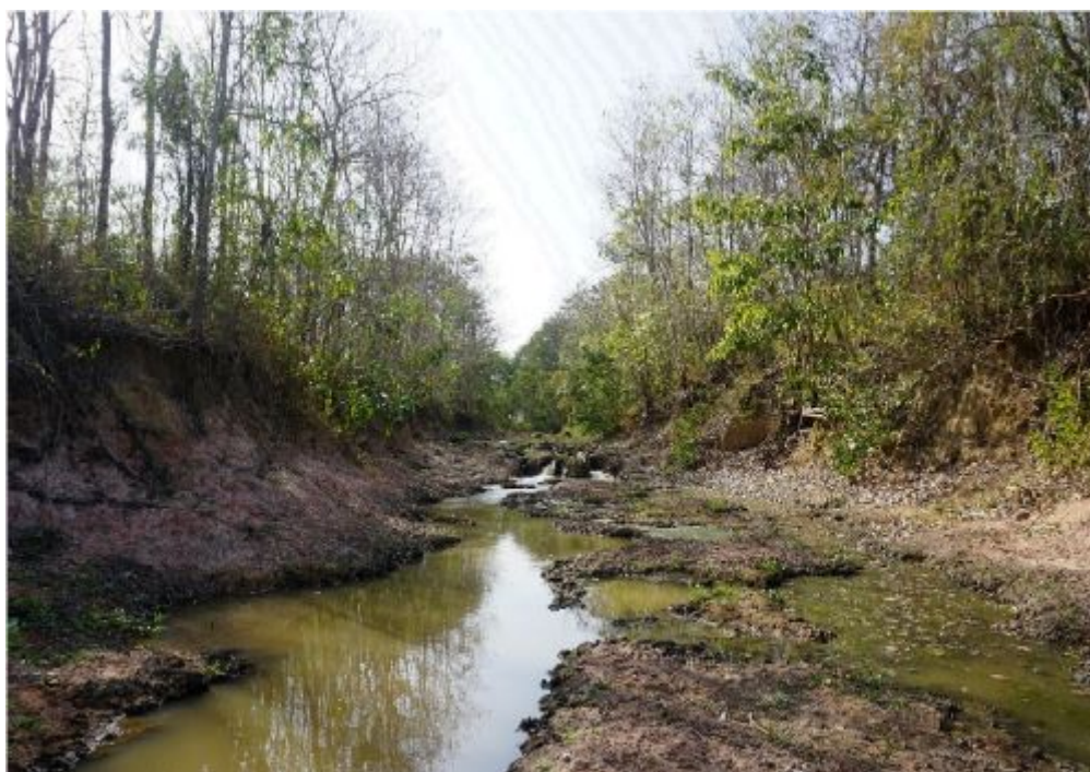
(B) Estado actual del caño.
