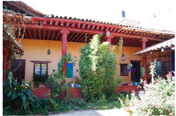
Figura 11 – Ejemplo de la espacialidad y constructividad de la vivienda purépecha. Vivienda de adobe de la cuenca lacustre de Pátzcuaro.
