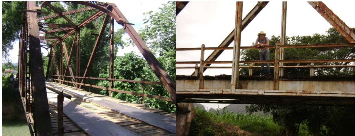
Figura 6 – Puentes de hierro
