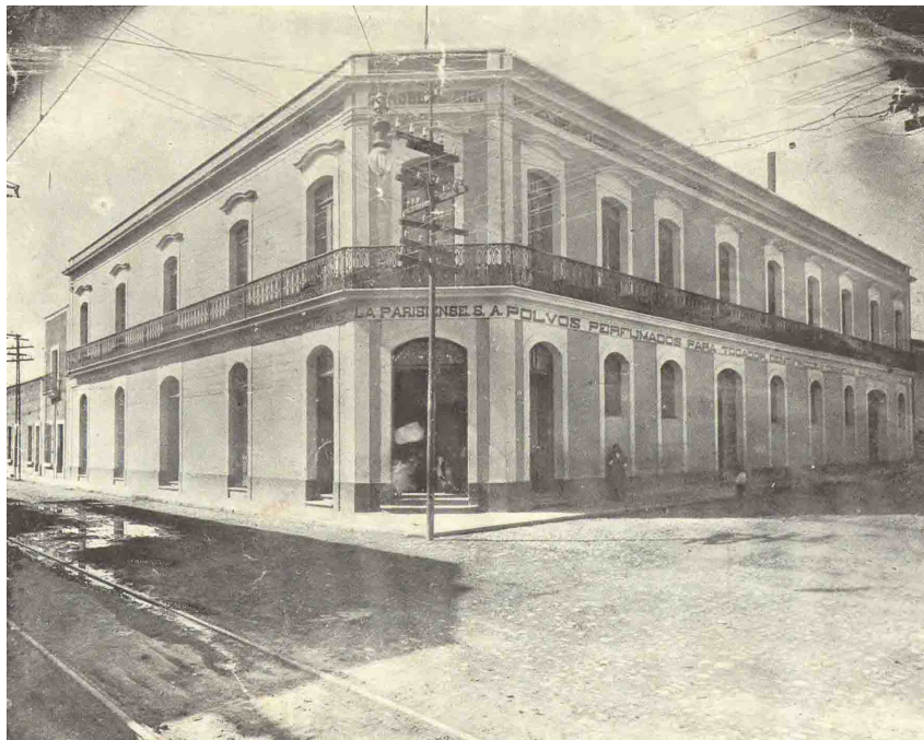
Figura 5 – La Parisiense 1, edificio desaparecido
