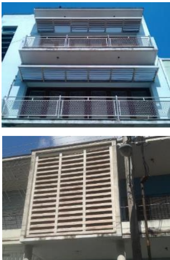
Figura 7 – Elementos de control ambiental en fachadas
