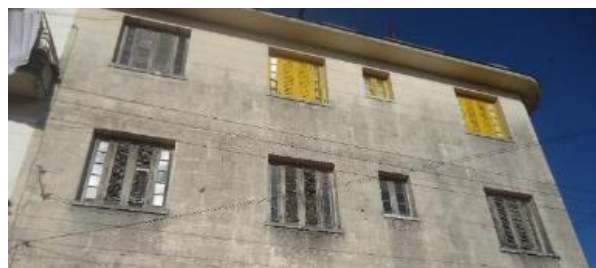
Figura 6 – Transformaciones en las proporciones y dimensiones de los vanos
