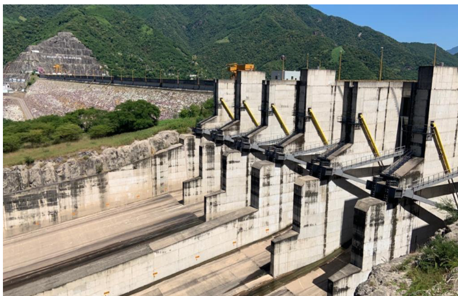
Figura 4 - Cortina de la presa hidroeléctrica Aguamilpa, Nayarit, México
