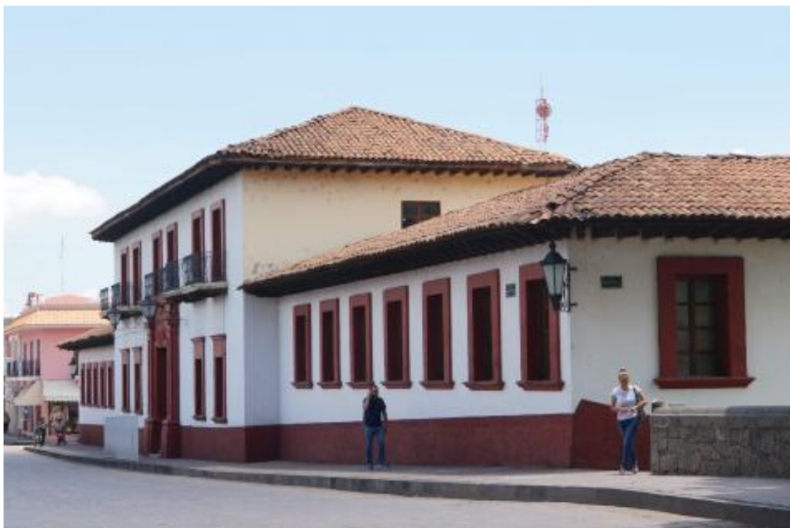
Figura 11 – Escuela Tipo Francisco I. Madero
